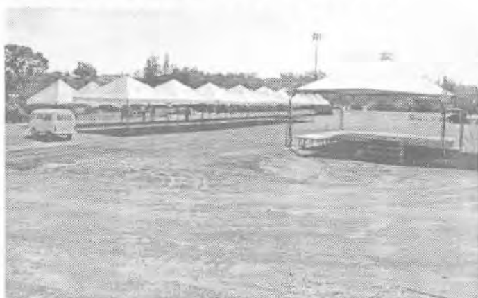
Montagem da infraestrutura, na quinta-feira
