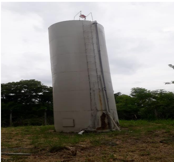
ITEM 13- Reservatório do Vale verde 120 m 3 Rua Santa Rita, s/n
