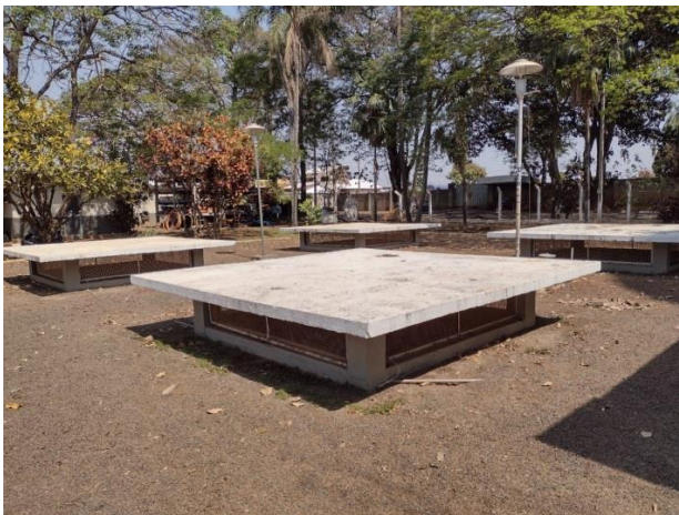
ITEM 1 - Reservatório enterrado Saudade 1000m 3 Rua Assumpta Bazani Fiorini, 60
