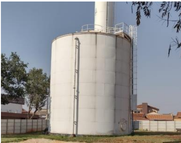
ITEM 3- Reservatório elevado Saudade 1200m 3 Rua Assumpta Bazani Fiorini, 60
