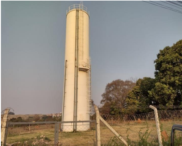
ITEM 6- Reservatório Padre Pedro Tomazzini 350m 3 Rua Benjamin Solera, 191
