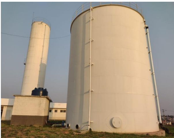
ITEM 4/ ITEM 5 - Reservatório Jardim Brasília I-250 m 3 e II 1200 m 3 Rua Assumpta Bazani Fiorini, 60
