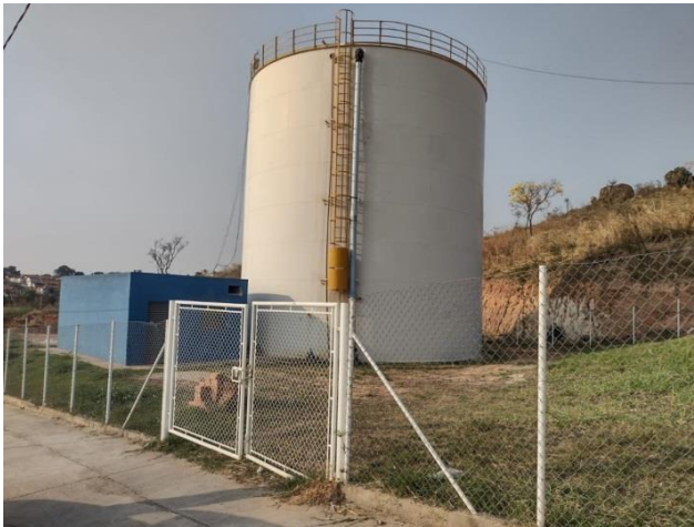
ITEM 11-Reservatório Bela Vista 1200m 3 Rua Fares Baracat, s/n
