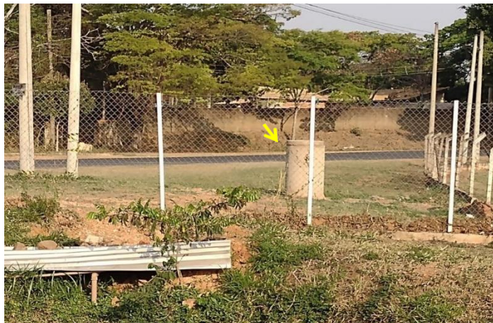
Figura: Poço Barreiros junto à captação por manancial
