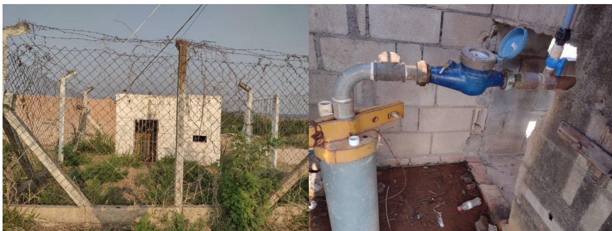
Figura: Poço Bela Vista 1
