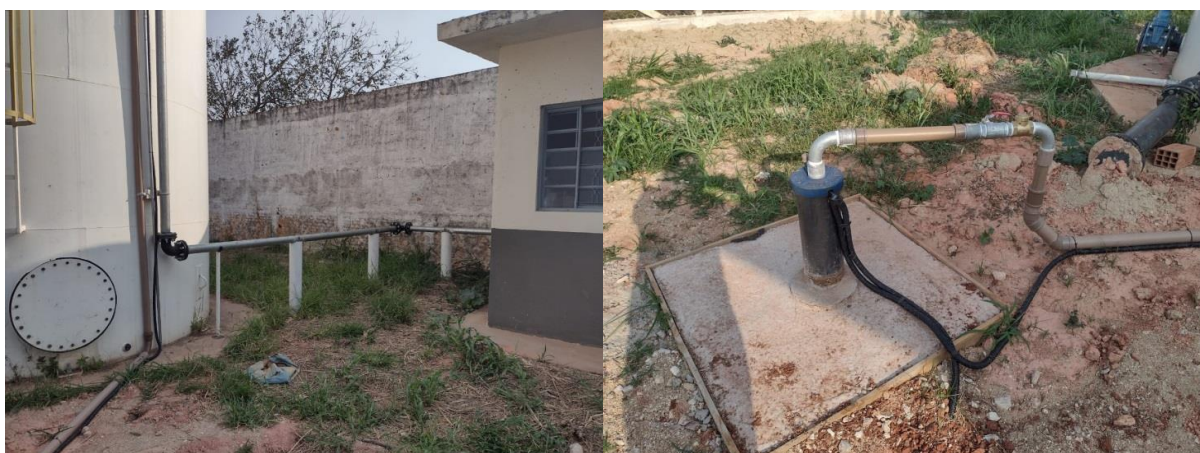
Figura: Poço Jardim dos Lagos
