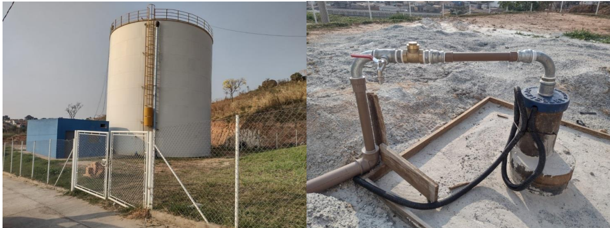
Figura: Poço Bela Vista 2
