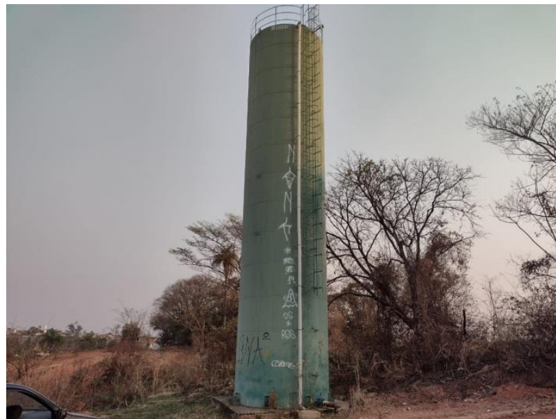
Figura: Reservatório Cidade Jardim 200m 3
