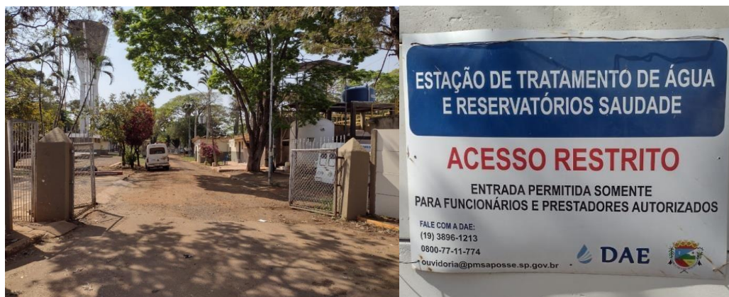
Figura: Acesso à ETA Saudade
