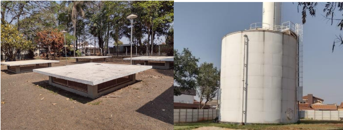
Figura: Reservatórios Saúde, enterrado e elevado.
