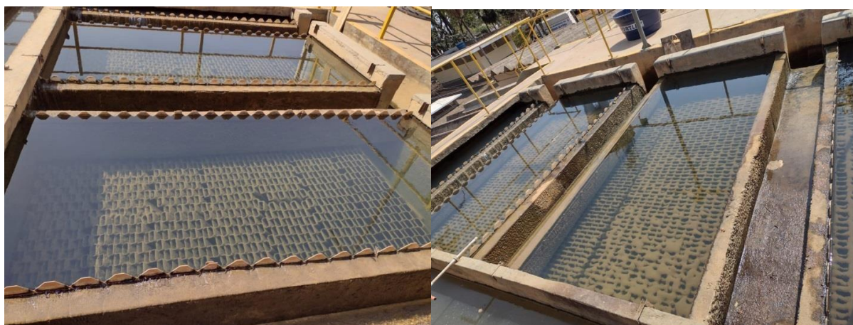
Figura: Unidades de filtração e detalhe de desnivelamento nas calhas de coleta de água decantada
