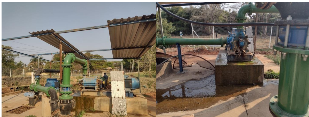
Figura: Vista da EEAB-2 e detalhe de vazamento
