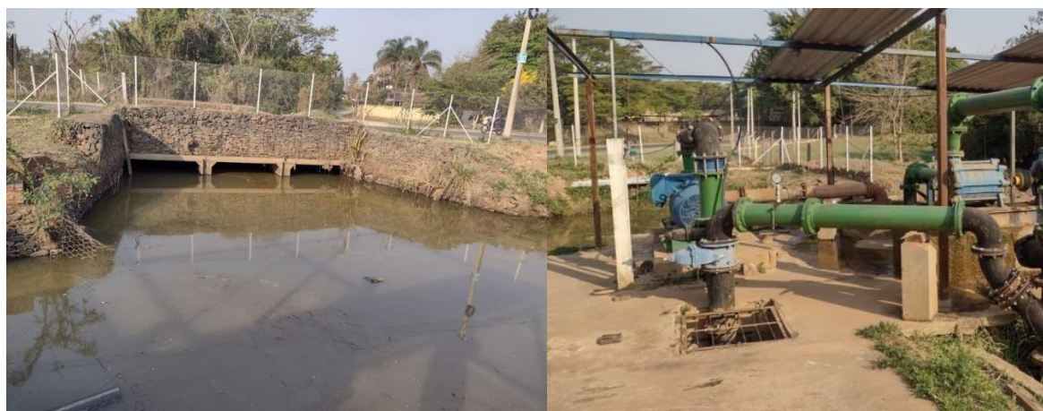
Figura: Captação e poço de sucção
