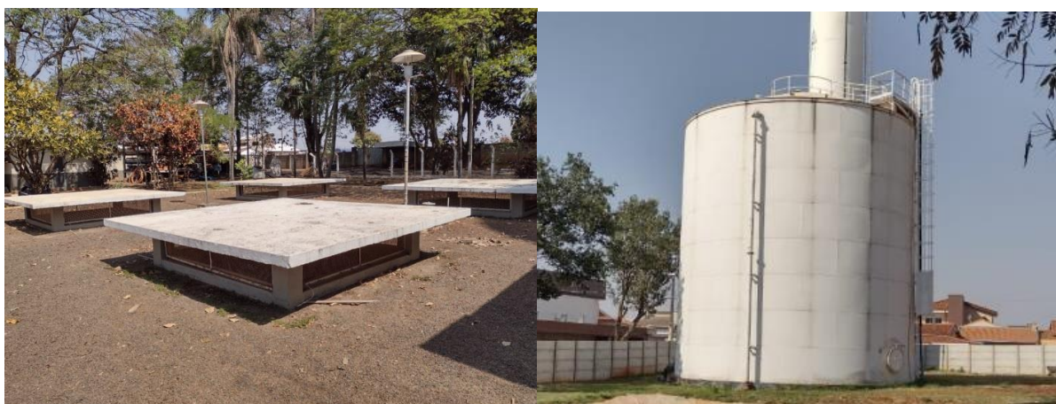
Figura: Reservatórios Saudade, enterrado e elevado.
